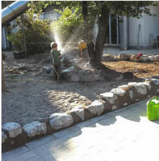
Die betonierten Steine als Sandkastenumrandung müssen gut „eingewaschen“ werden.
