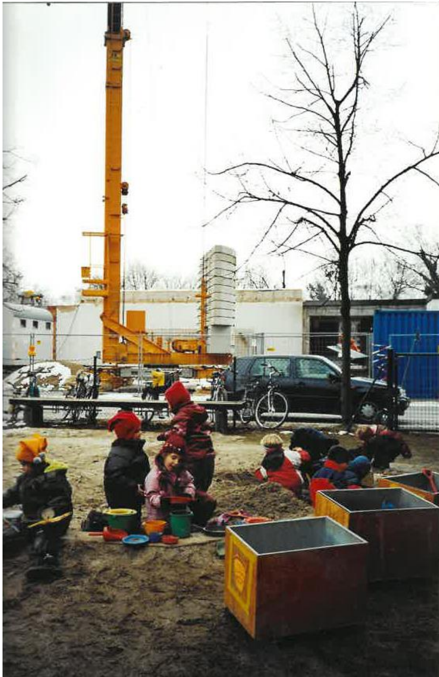
Blick auf die Baustelle
