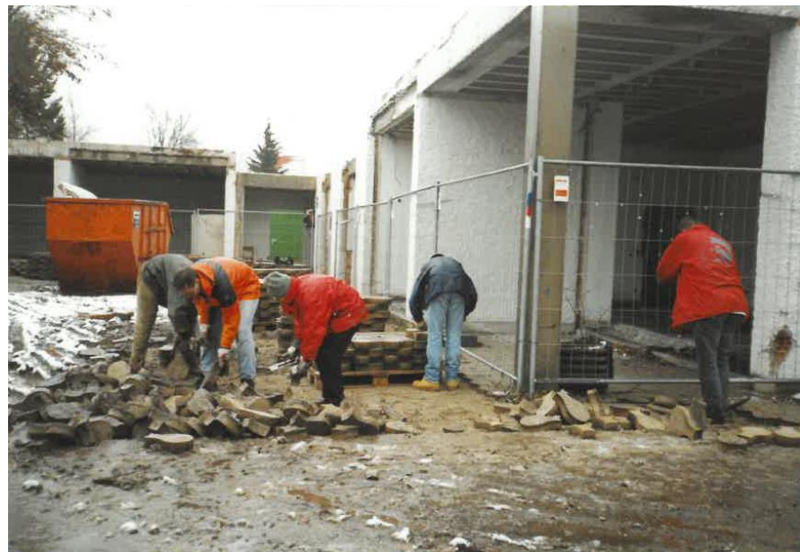
Das Haus ist entkernt und die Pflasterstein werden mit Hilfe der Eltern abgetragen
