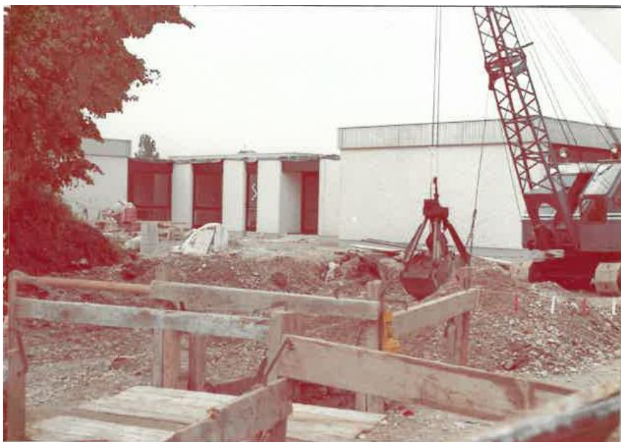
Kurz vor der Fertigstellung im September 1973 Blick vom Kirchplatz aus
